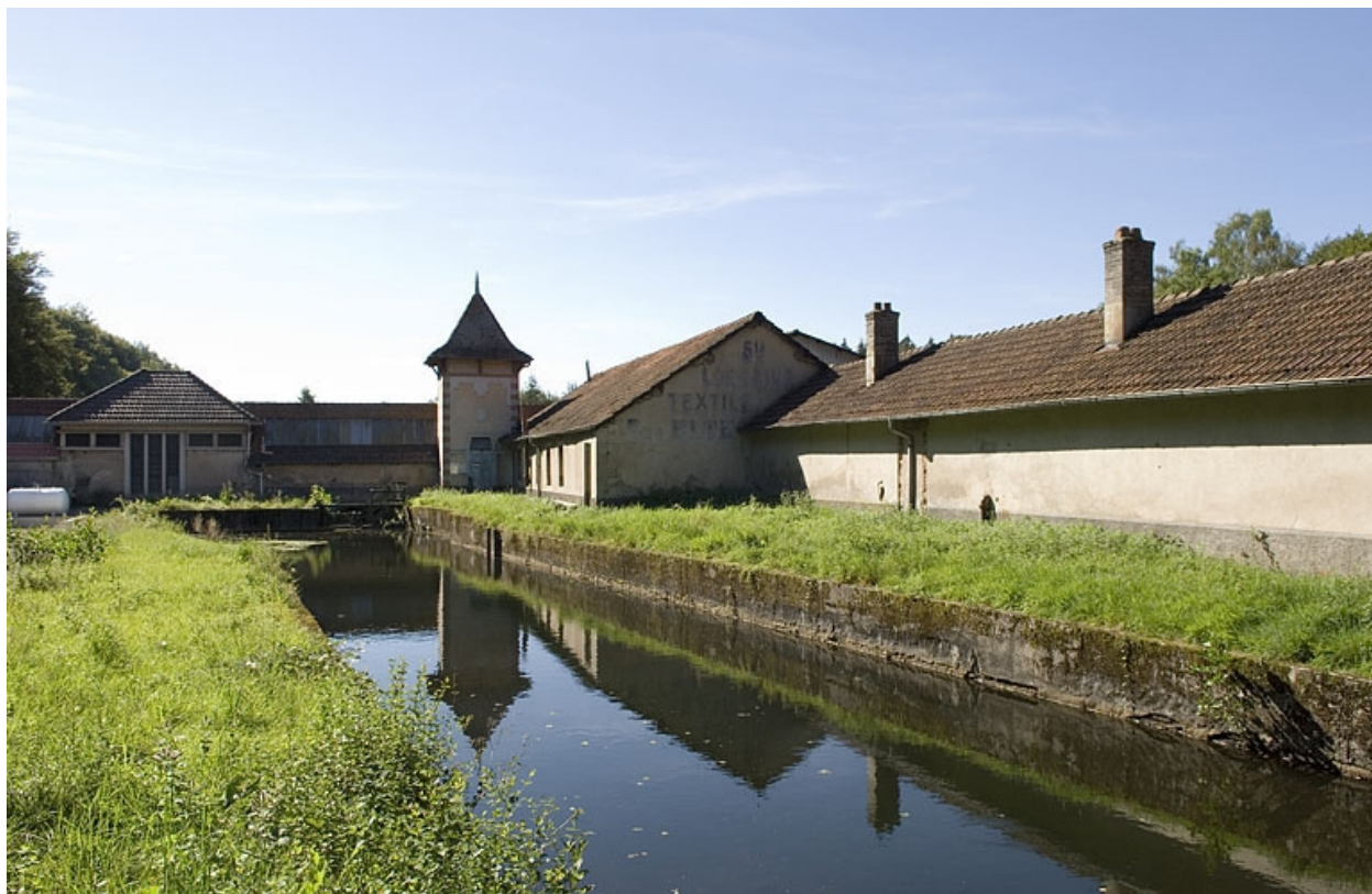
Ateliers et bief d'amenée.
