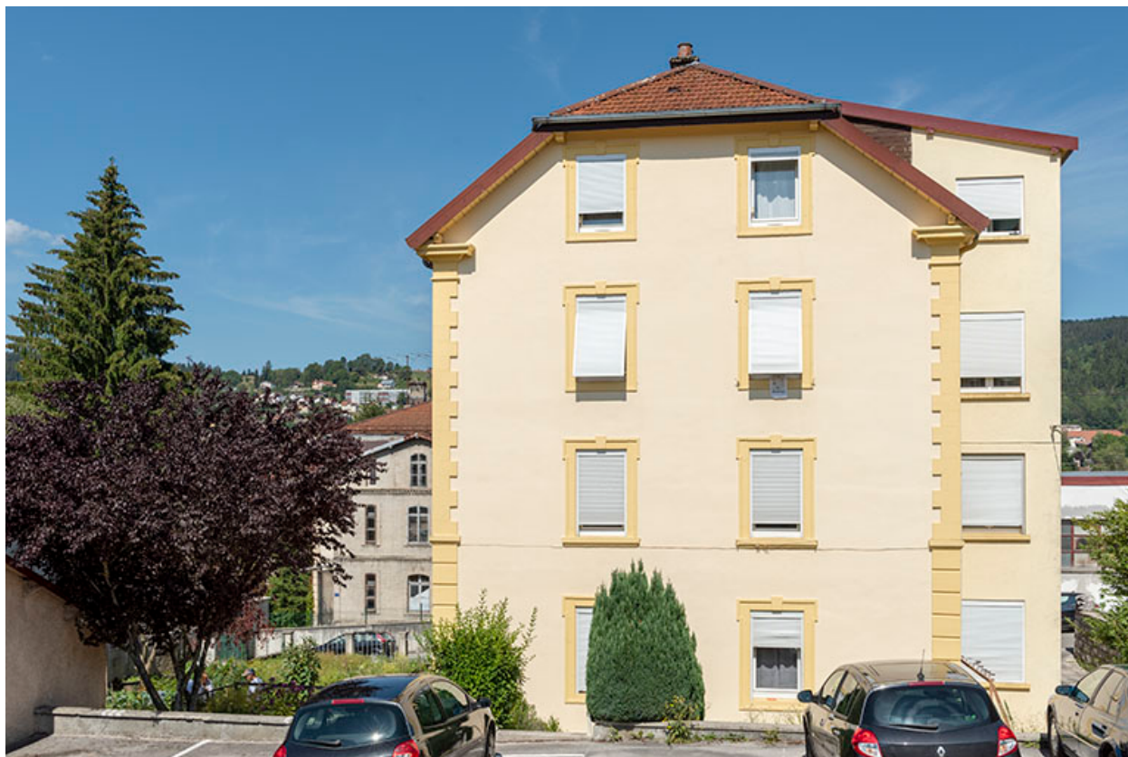
Façade latérale droite.
