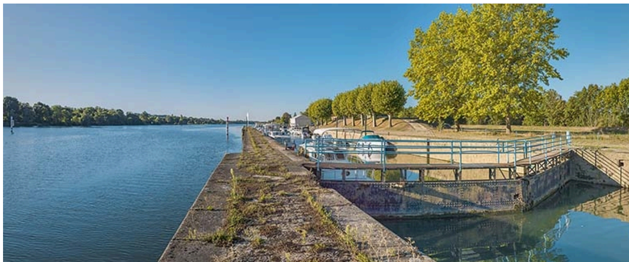
Le sas et les portes amont de l'ancienne écluse de Gigny.
