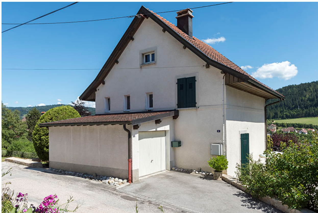
Façades antérieure et latérale droite.
