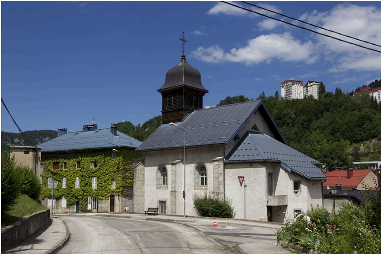
Façade latérale droite.
