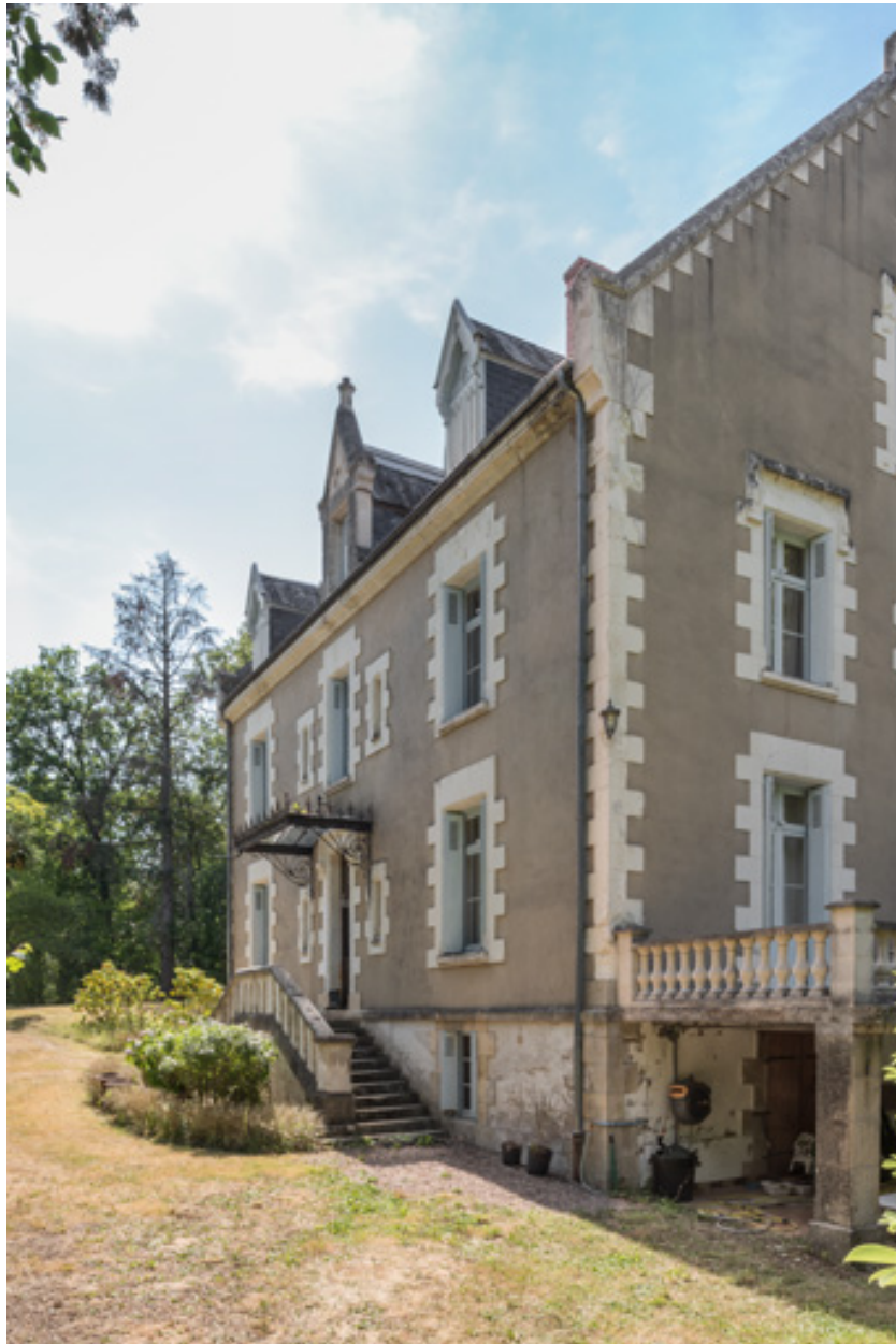
Façade sud-est, vue depuis l'est.
