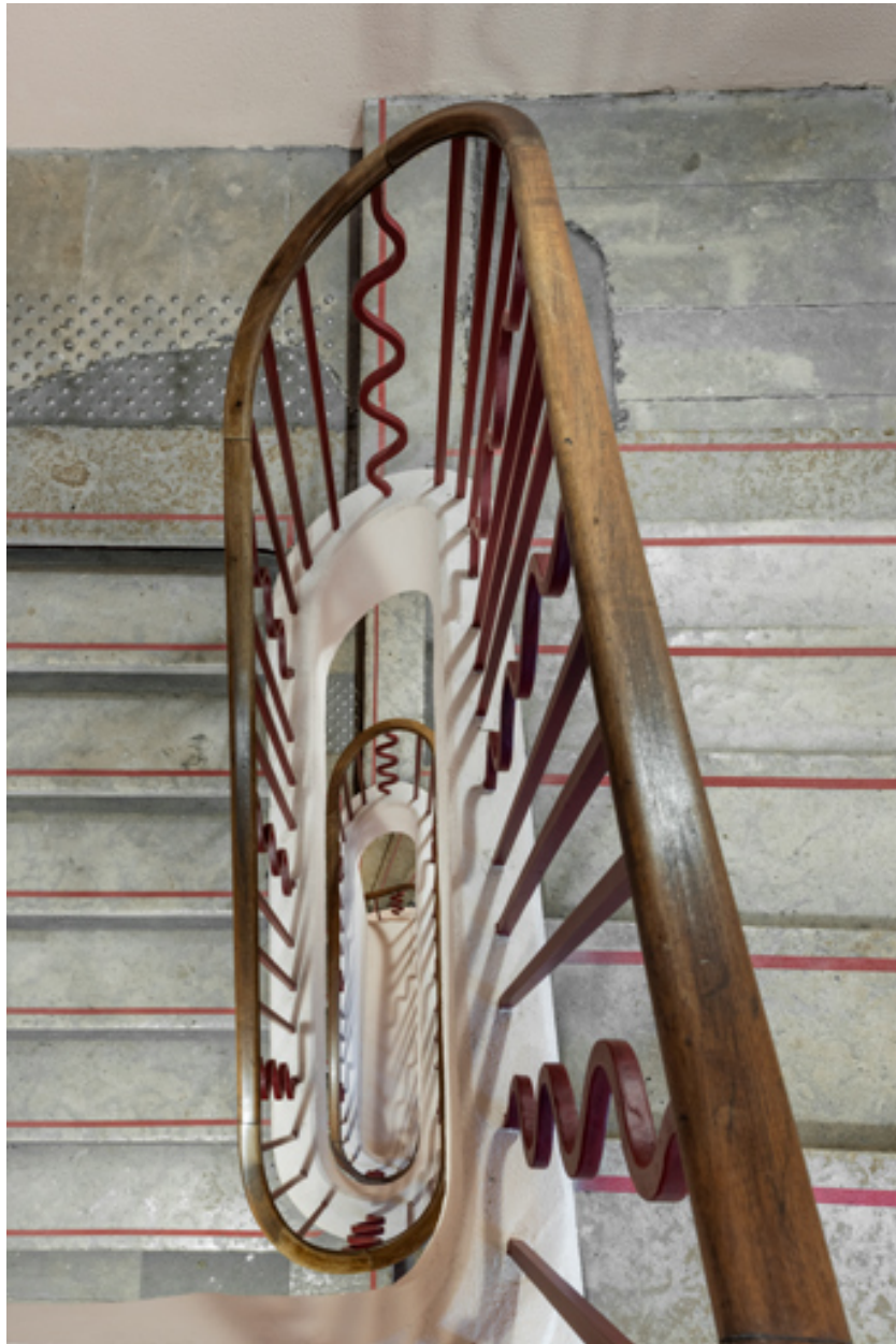
Escalier côté jardin : vue plongeante.
