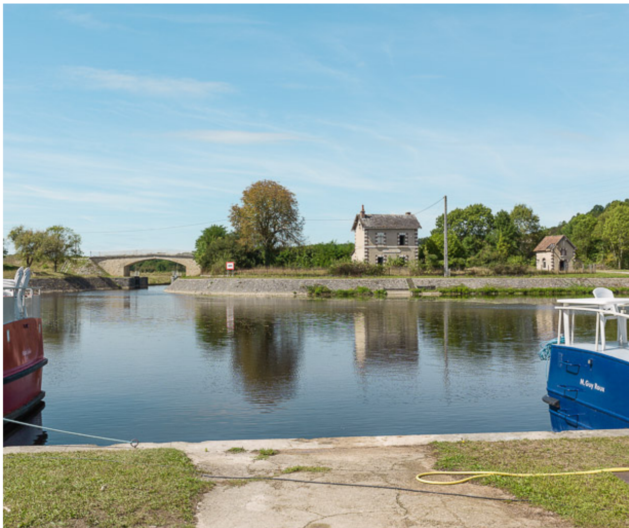
Vue d'ensemble du site.
