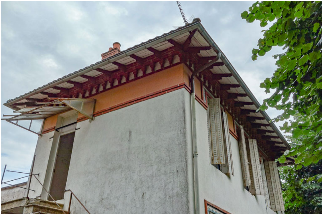
Élévation du pavillon du gardien, fenêtrés de l'étage et toiture.
