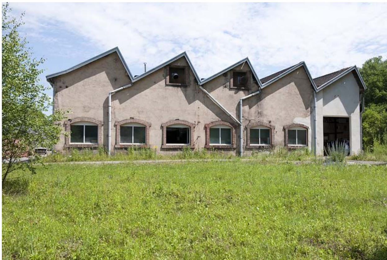
Atelier de fabrication des pompes. Mur-pignons ouest.
