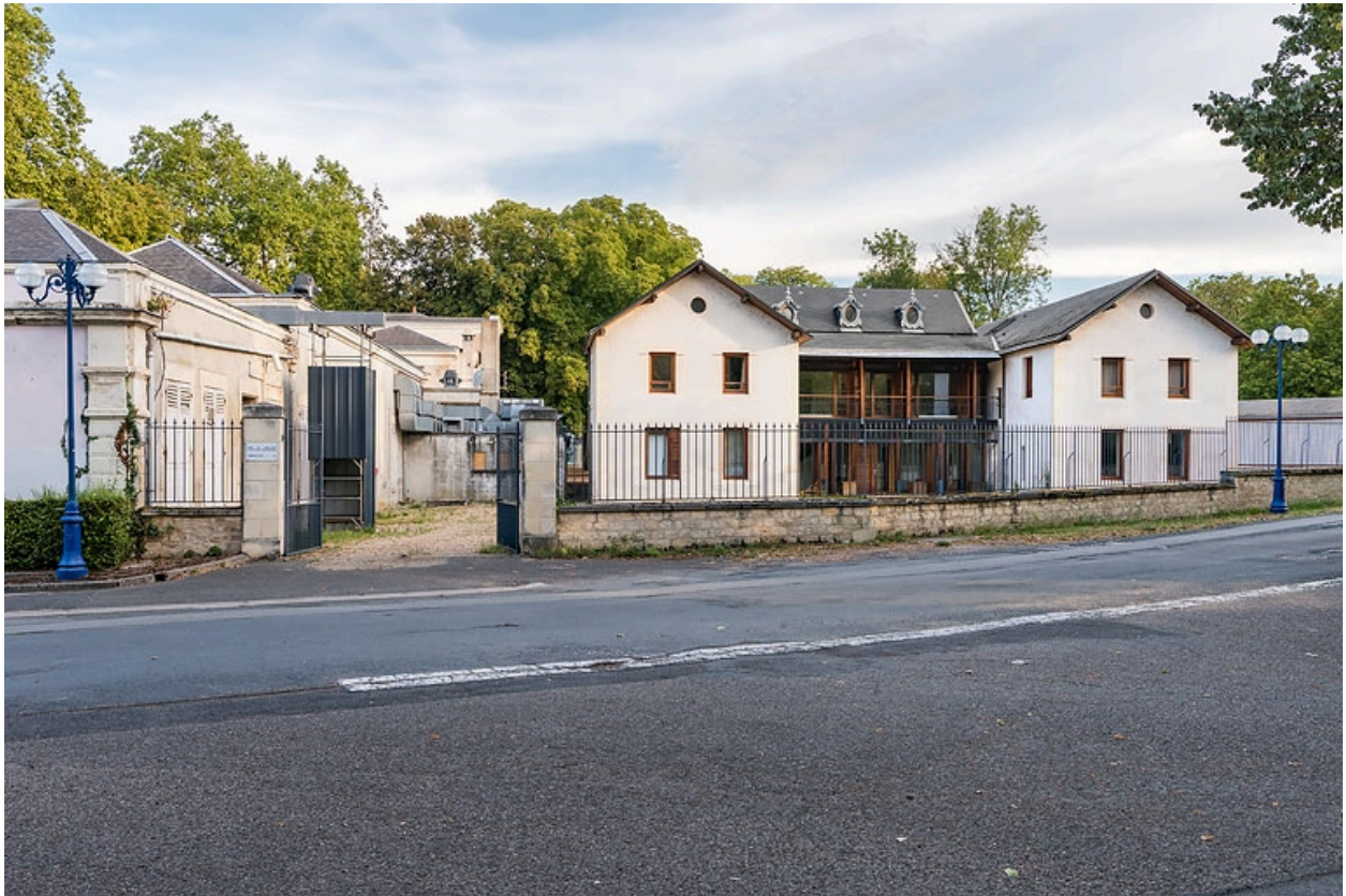
Façade principale après la transformation de l'édifice en centre d'art contemporain (Parc Saint-Léger).
