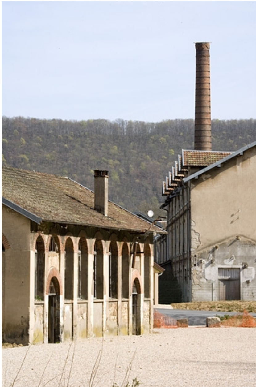
Façade de l'atelier de réparation et cheminée, depuis l'aire des déchets.
