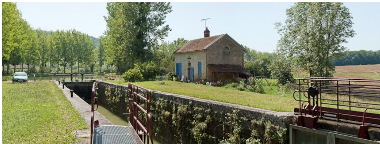
Vue d'ensemble du site d'écluse.
