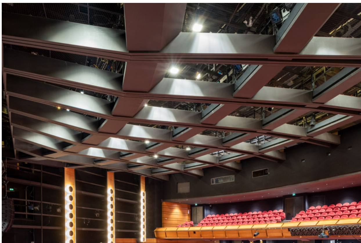
Maison de la culture, grande salle : balcon et charpente.
