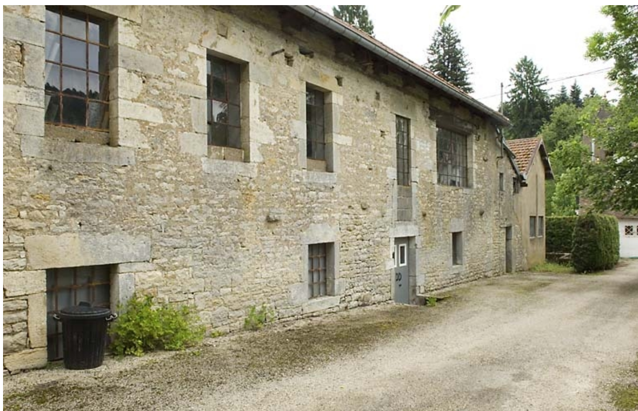
Façade ouest de l'atelier de fabrication.
