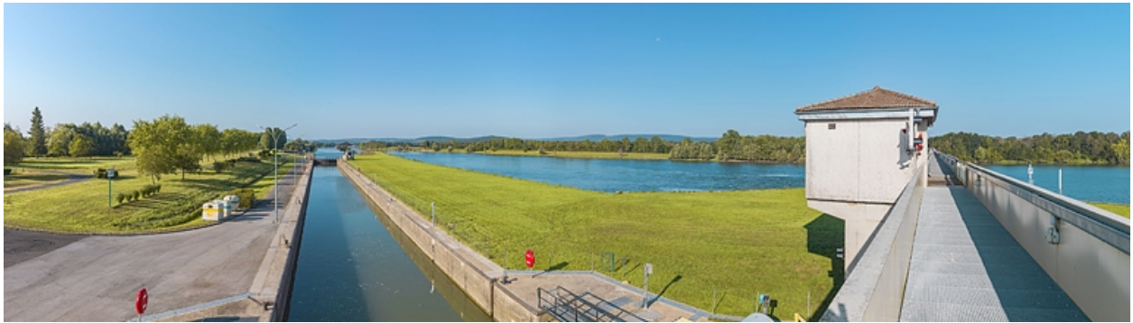
Le sas à grand gabarit, vu depuis la passerelle du barrage.
