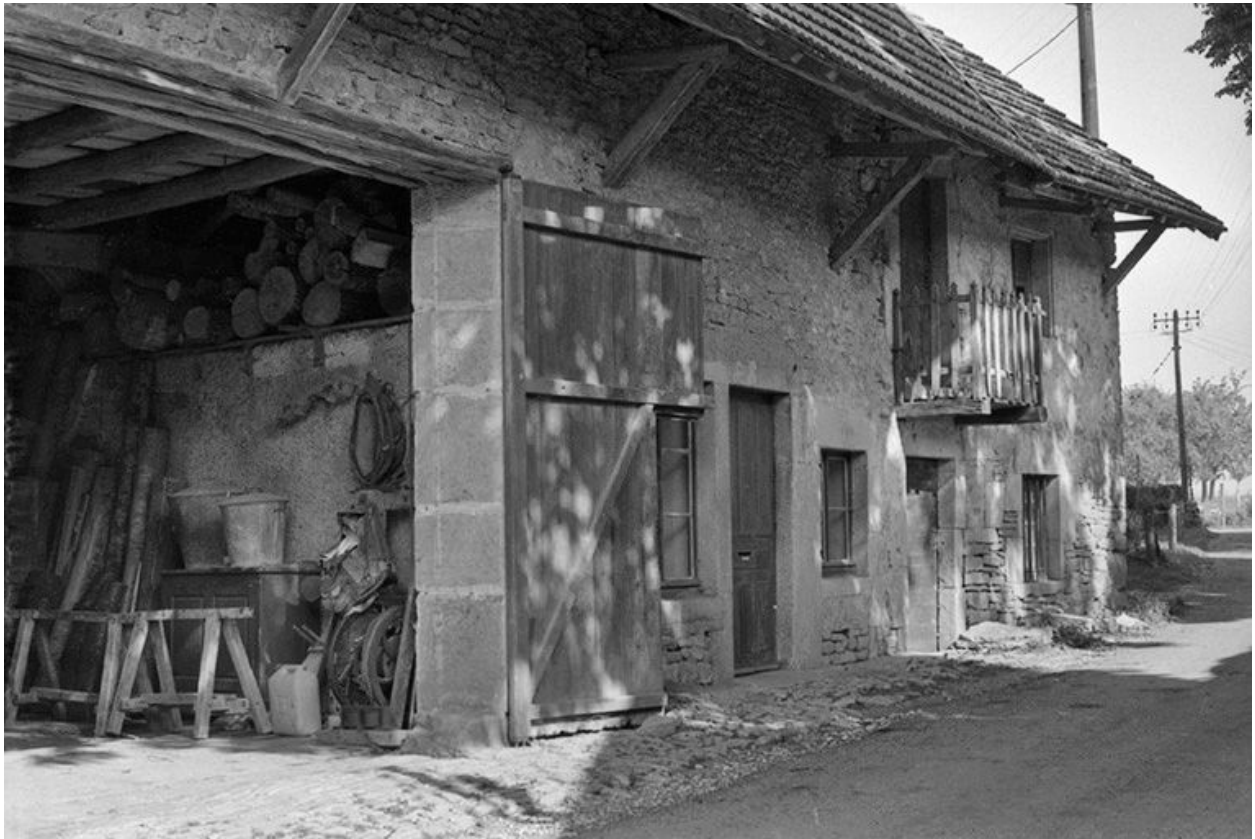
Ferme située 11 rue de Tarcenay (en ruine en 2019).
