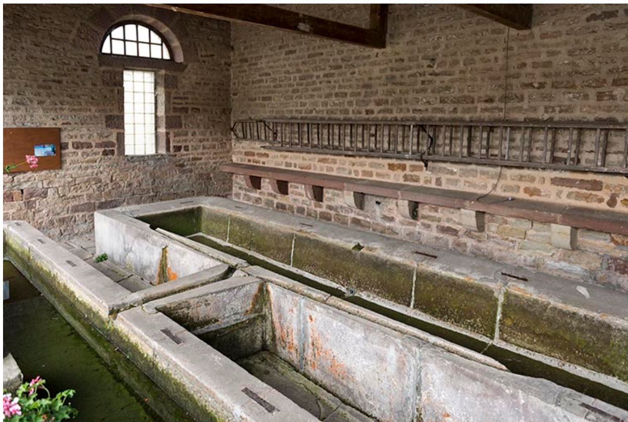
Bassins du lavoir.
