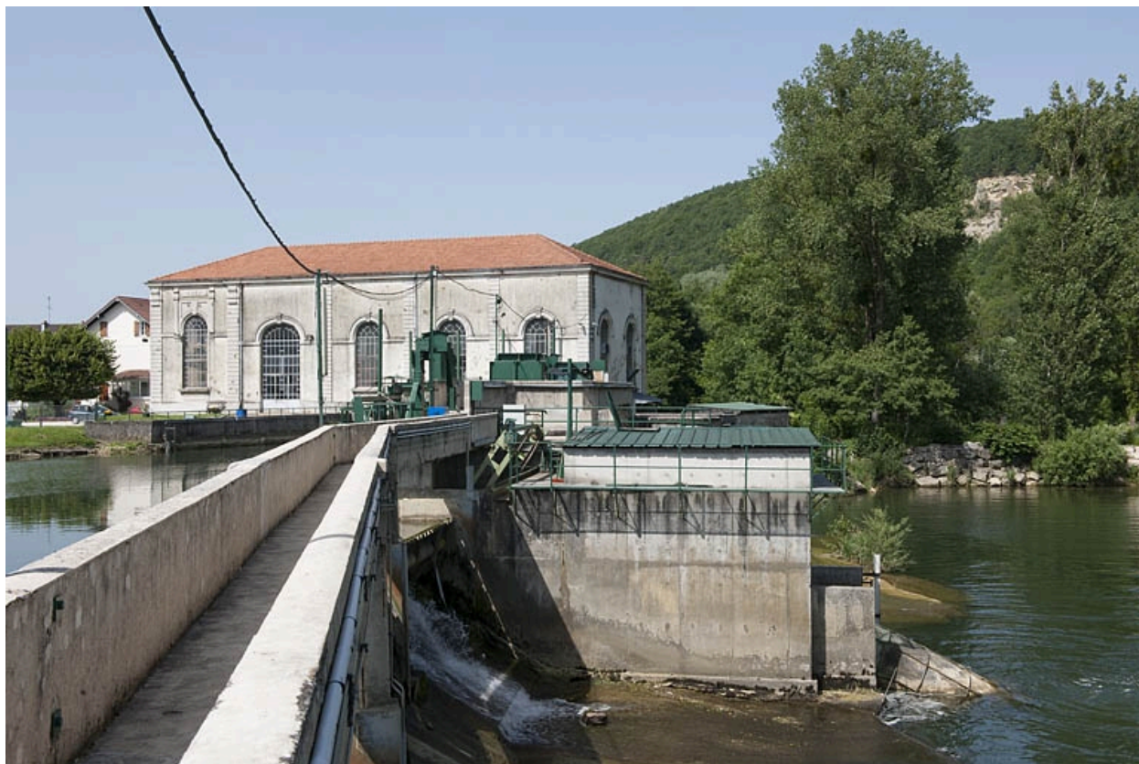
Extrémite nord du barrage et façade sud de la centrale.
