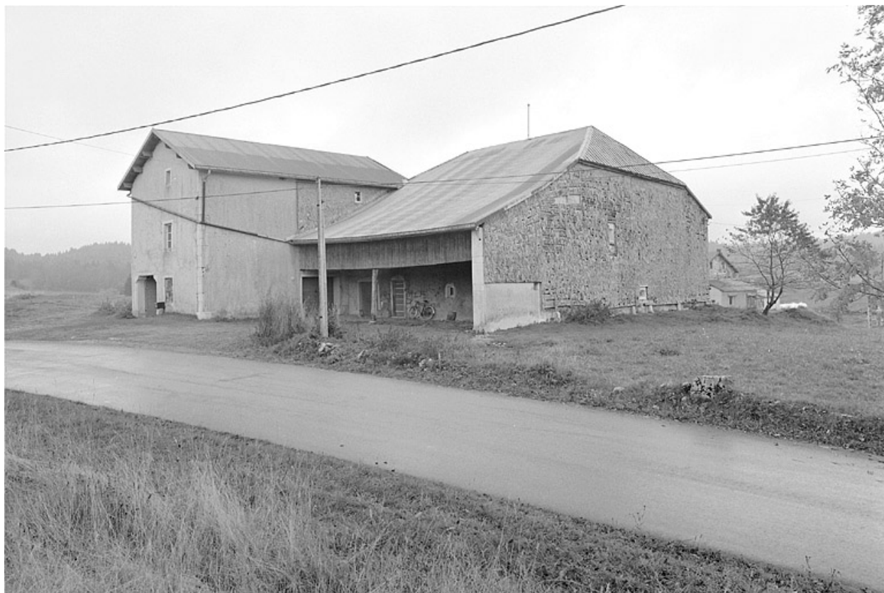
Façade postérieure et face ouest.
