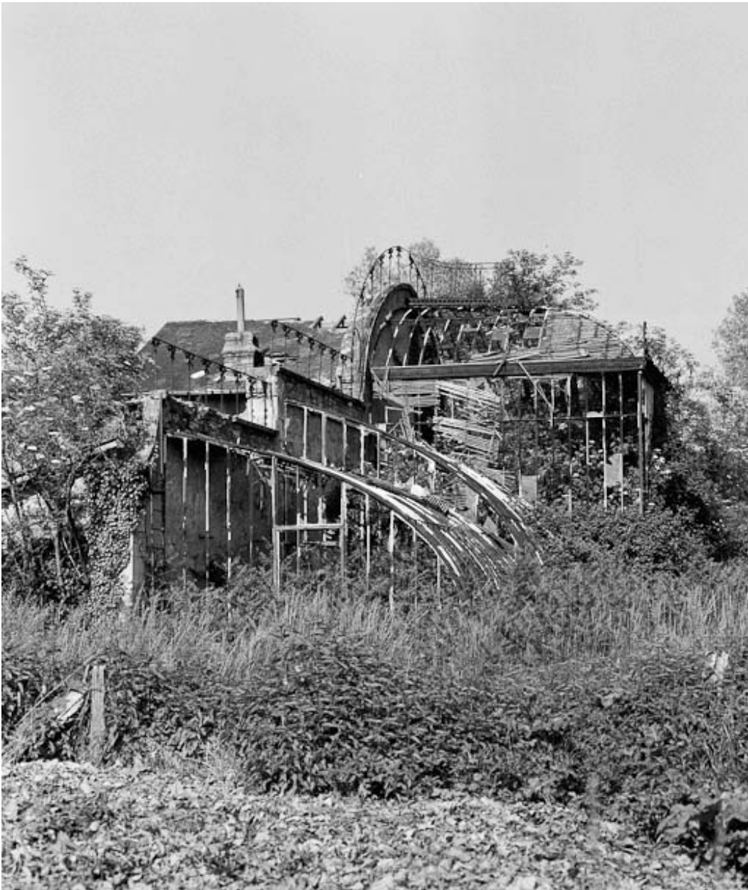
Vestiges de la serre envahie par la végétation, vue prise en 1984.
