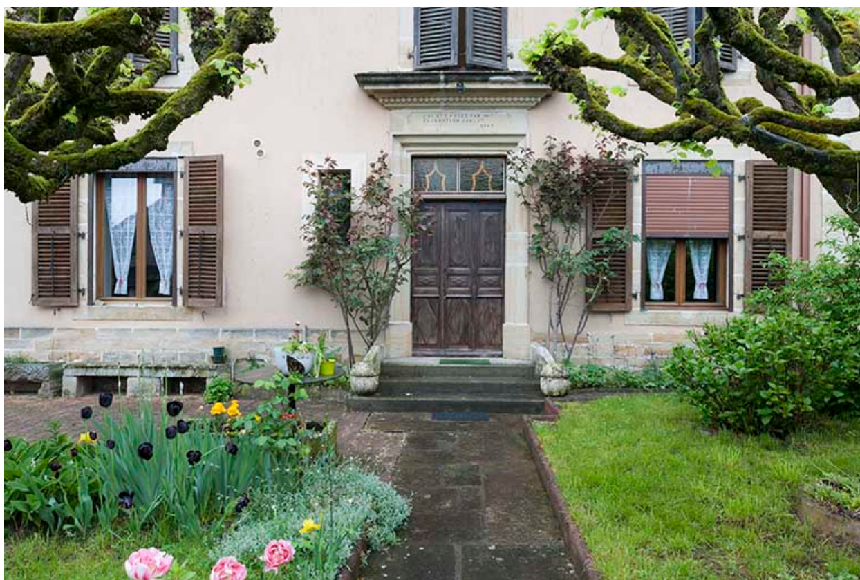
Le rez-de-chaussée, façade principale.
