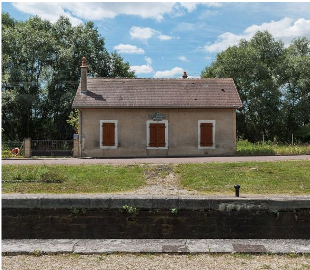
La maison éclusière de face.
