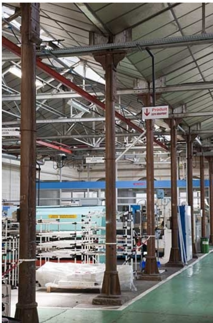
Atelier de fabrication (aujourd'hui de maintenance).
