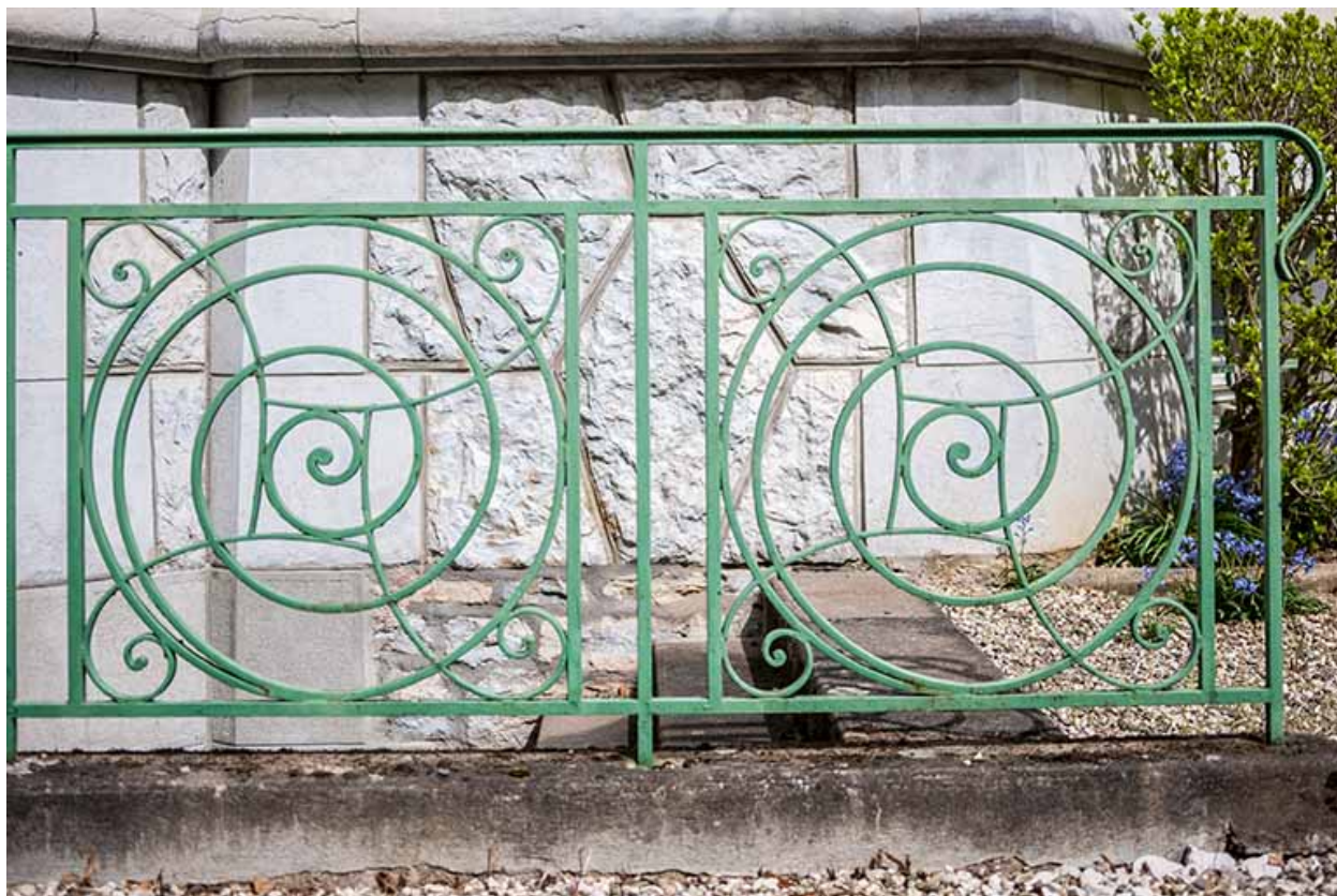
Façade latérale gauche : ferronnerie du garde-corps de l'escalier desservant le sous-sol.
