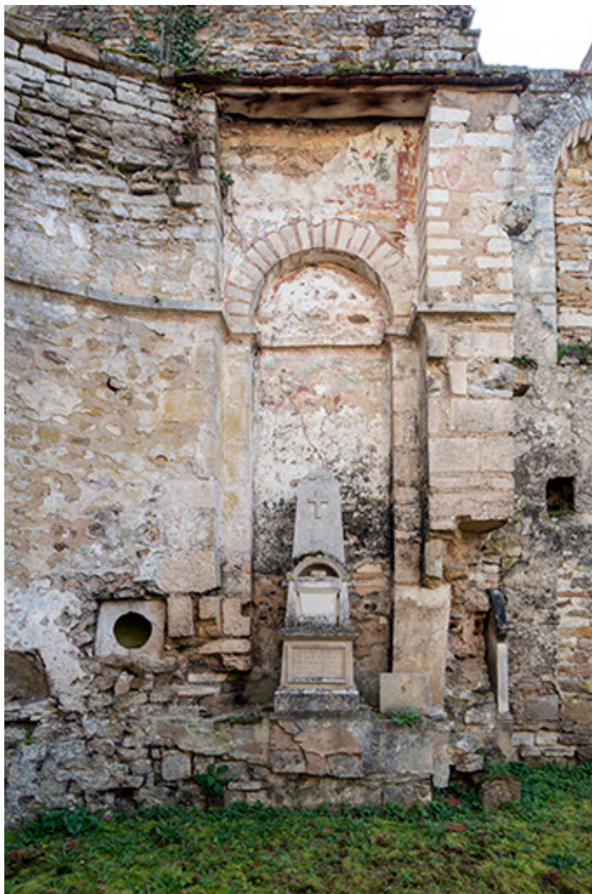
Le mur sud de l'abside.
