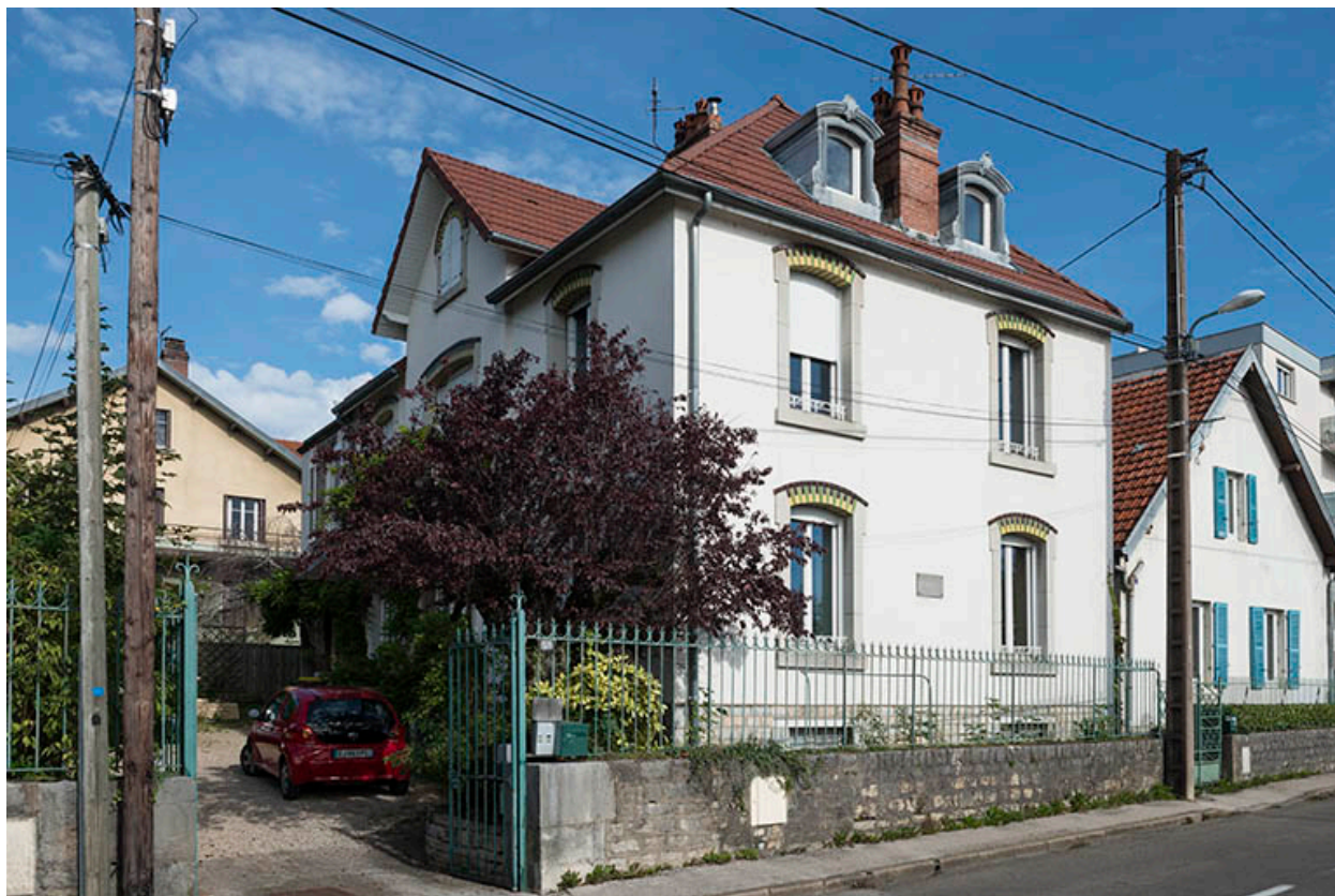
Vue de trois quarts depuis la rue.
