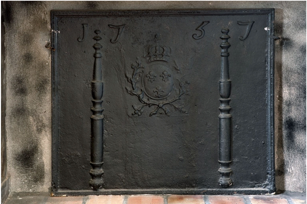
Intérieur : détail de la plaque de cheminée de l'ancienne cuisine.
