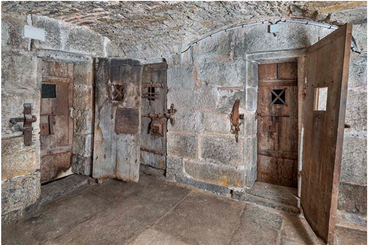
Portes doubles des cellules.
