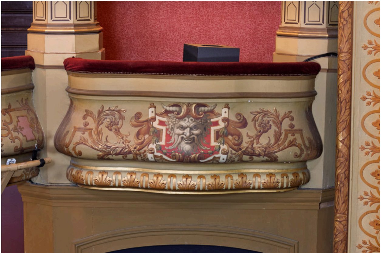
Garde-corps de la loge d'avant-scène (côté jardin) au 1er balcon.
