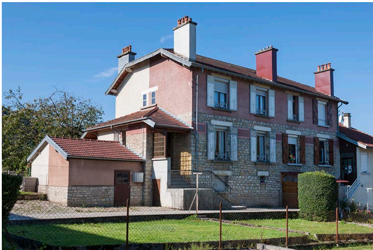
Maison à quatre logements. Vue trois quarts.
