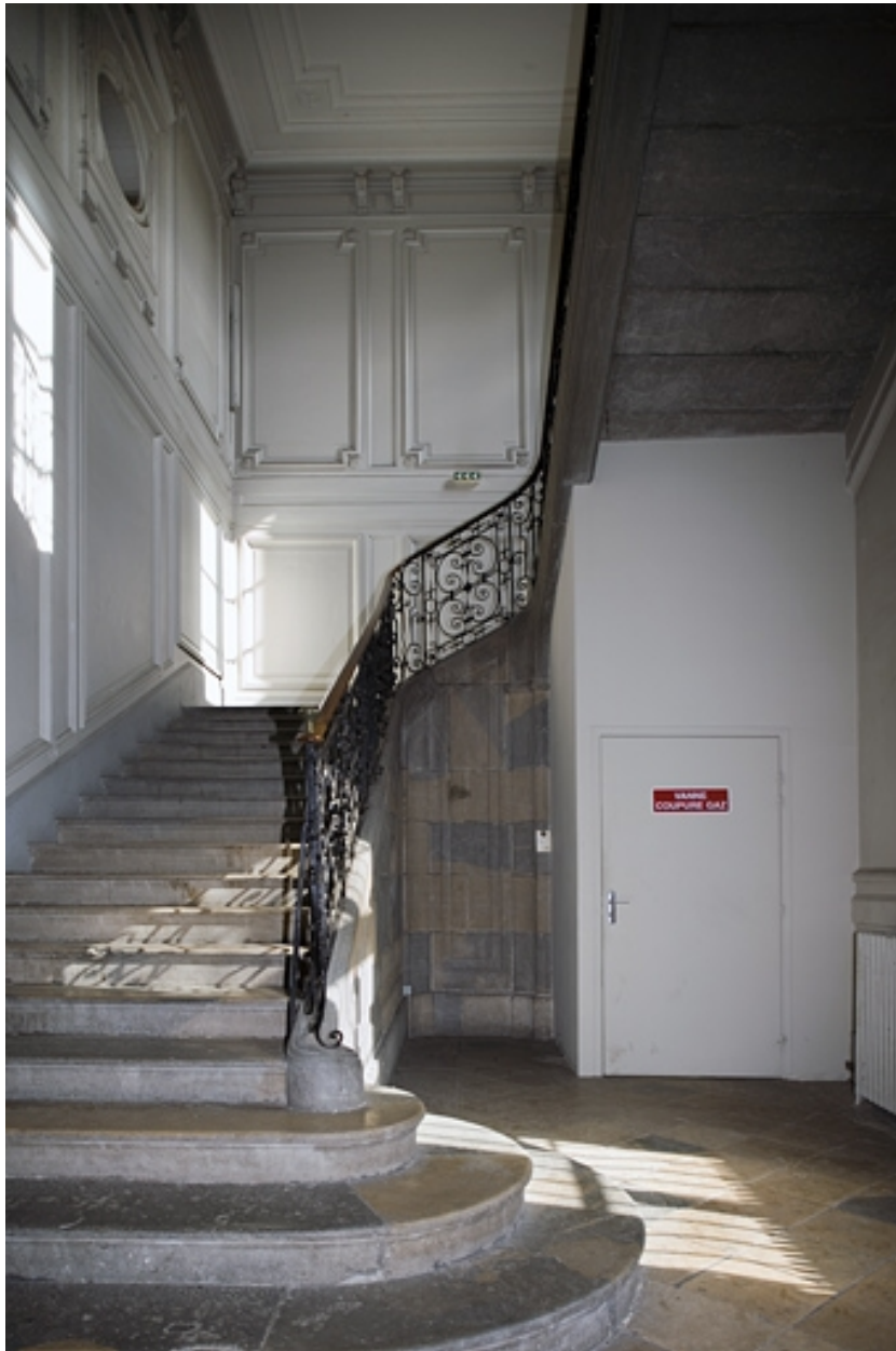
Vue d'ensemble de l'escalier.
