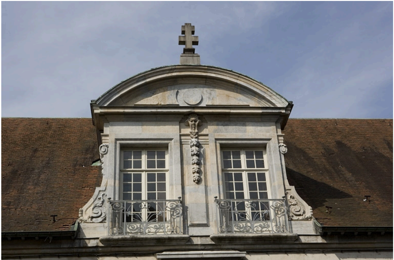
Détail d'une mansarde.
