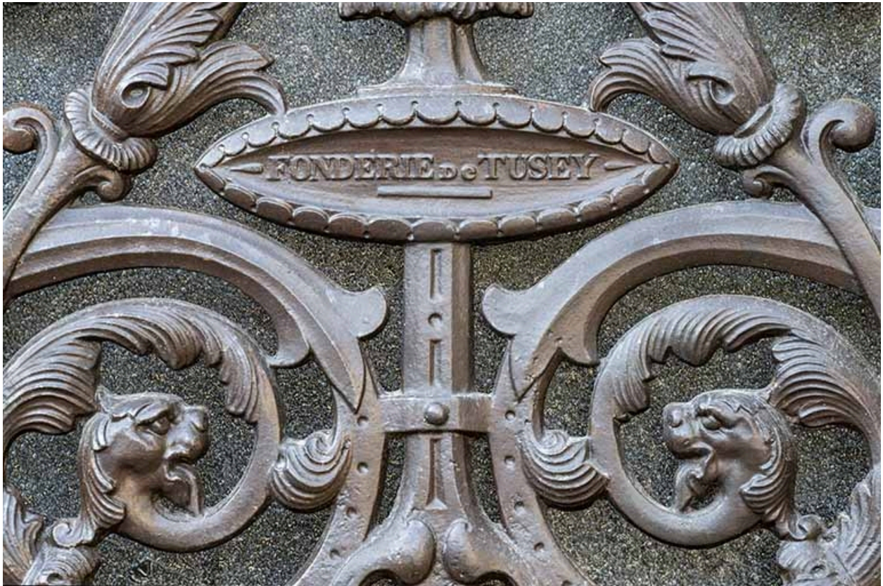
Détail de la grille droite de la porte cochère avec marque de fabrique : "Fonderie de Tusey".
