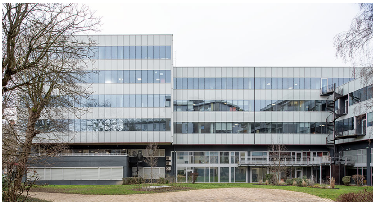
Façade sud-est, partie donnant sur le jardin.
