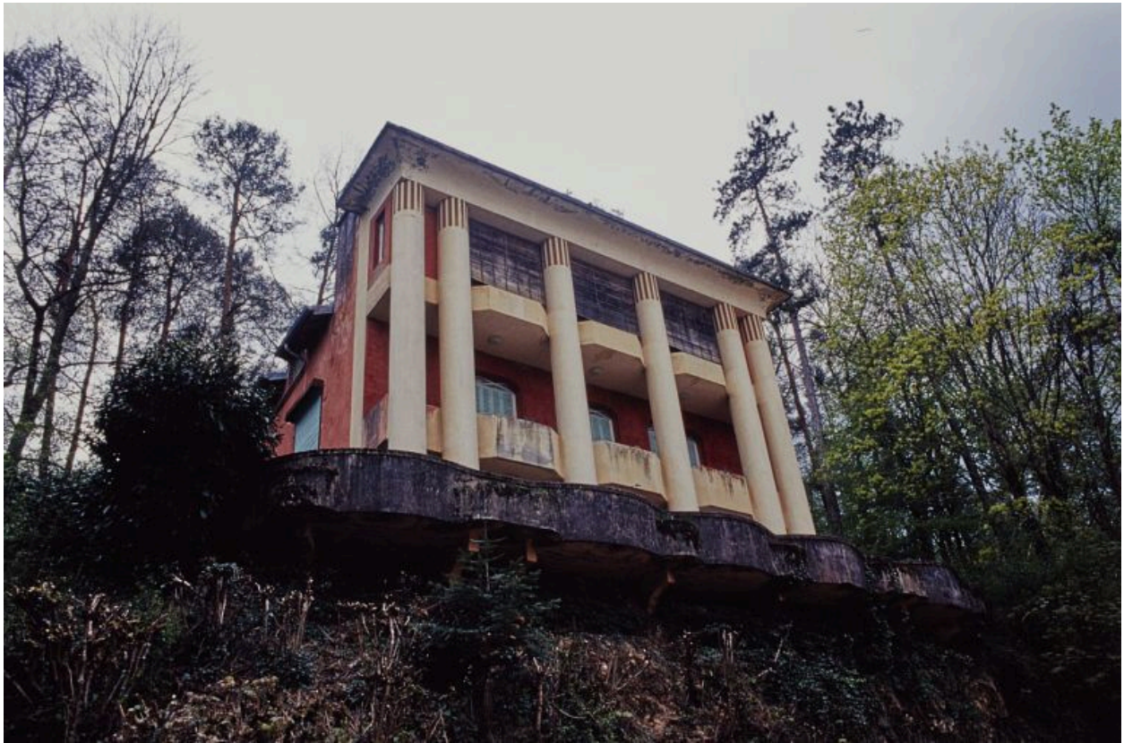
Façade nord, vue en contre-plongée.
