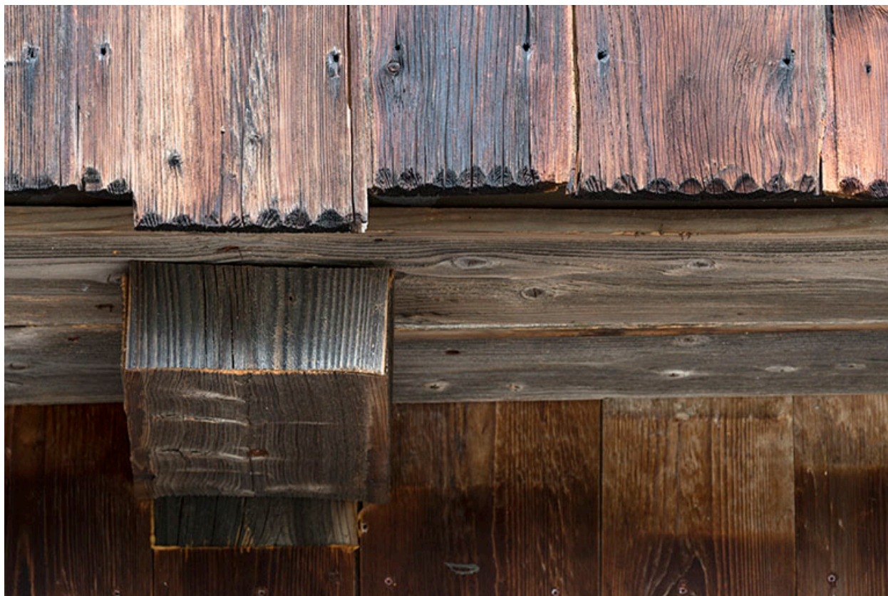
Extrémité des planches de la lambrichure.
