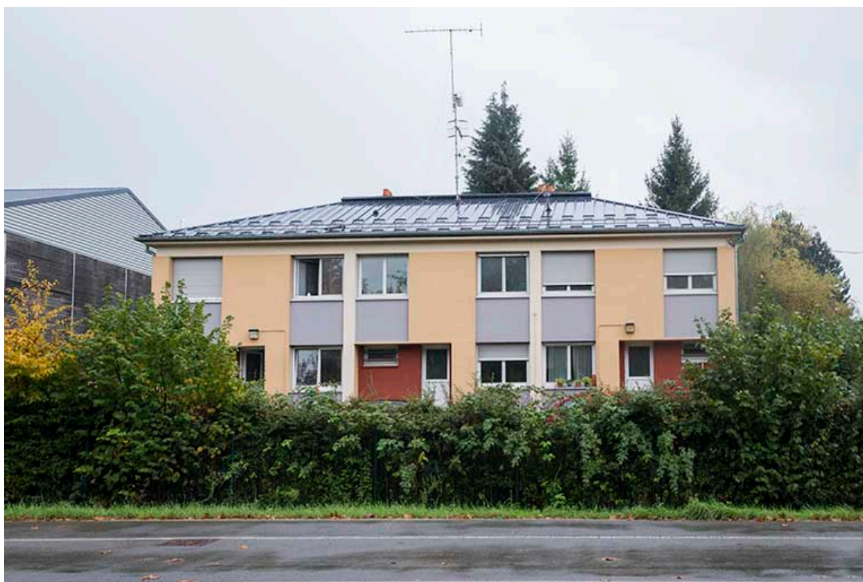
Façade nord du bloc des logements nord.
