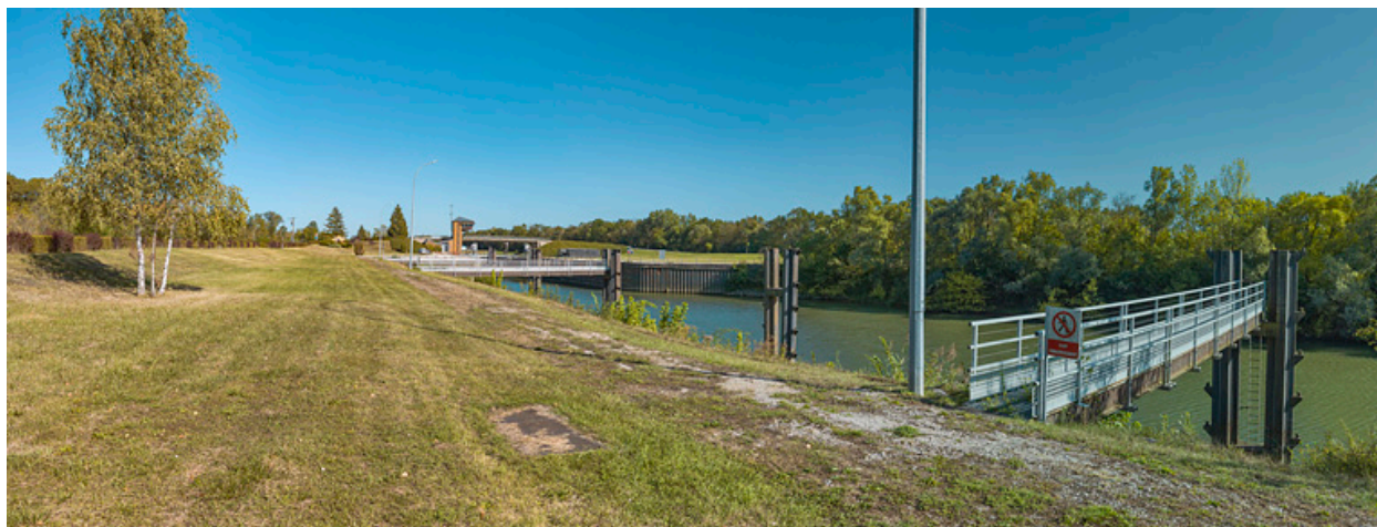
Le site d'écluse vu d'aval.
