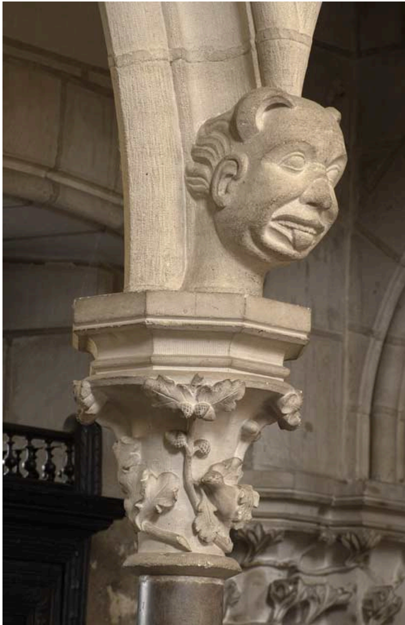
Bâtiment du réfectoire : réfectoire néo-gothique, décor sculpté.
