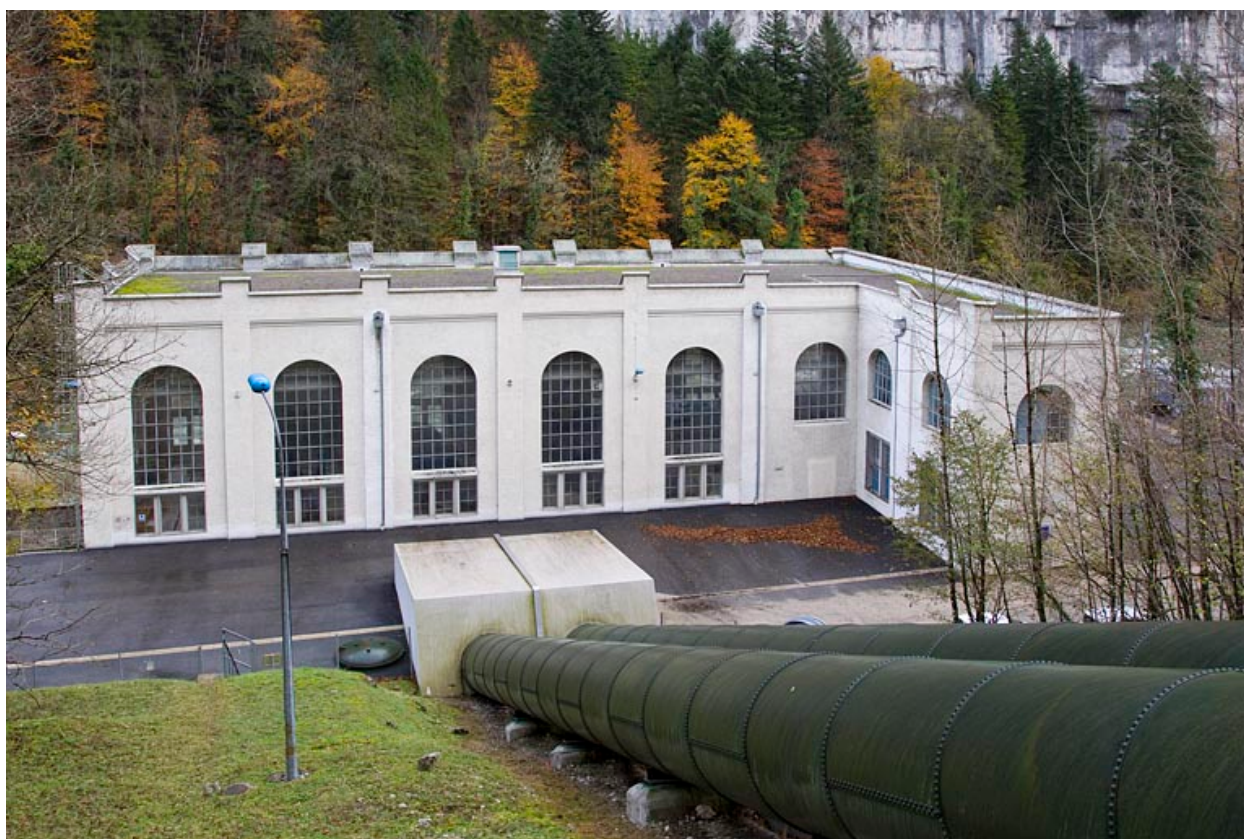
Centrale : façade latérale droite (élévation orientale).
