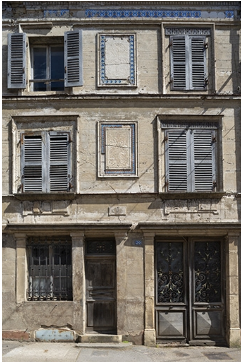
Le rez-de-chaussée et les deux étages carrés.
