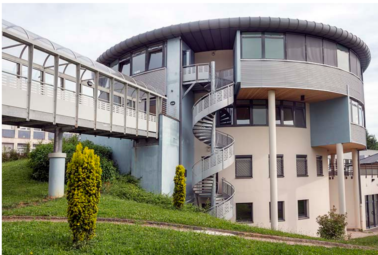
Passerelle, tour et son escalier au sud-ouest.
