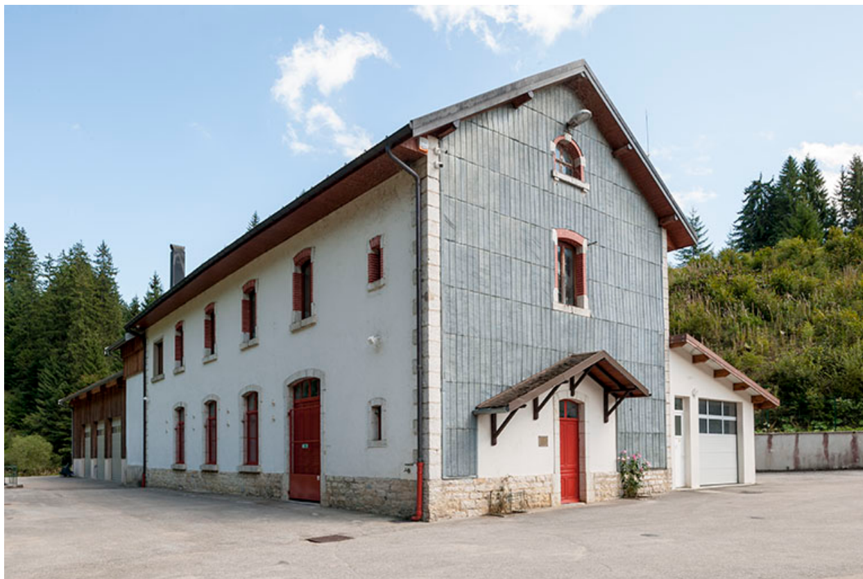
Centrale vue de trois quarts droite.
