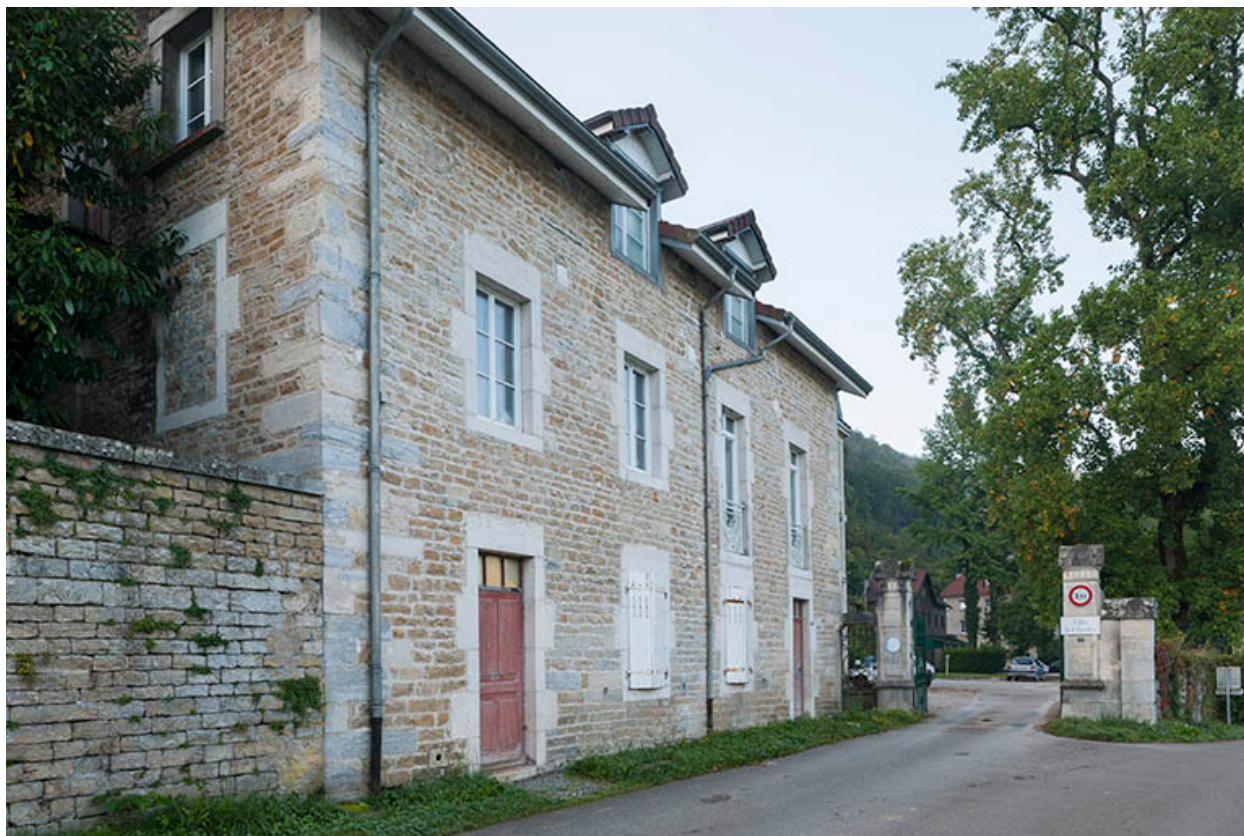
La conciergerie et l'entrée du site.
