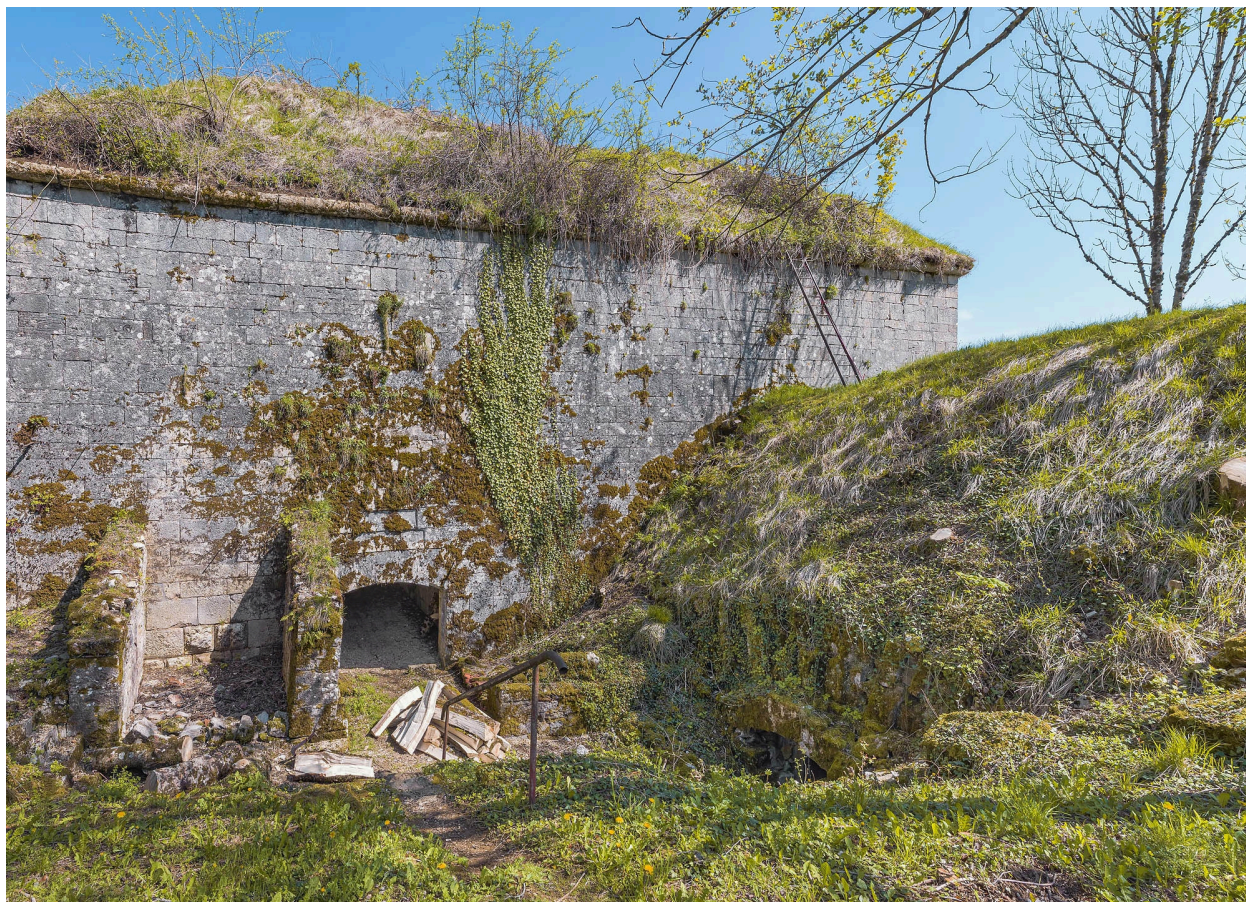
Traverse d'accès à la plateforme du demi-bastion ouest.
