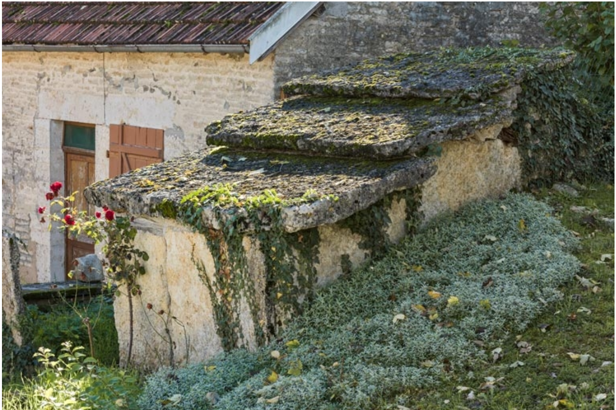
Détail de la toiture.
