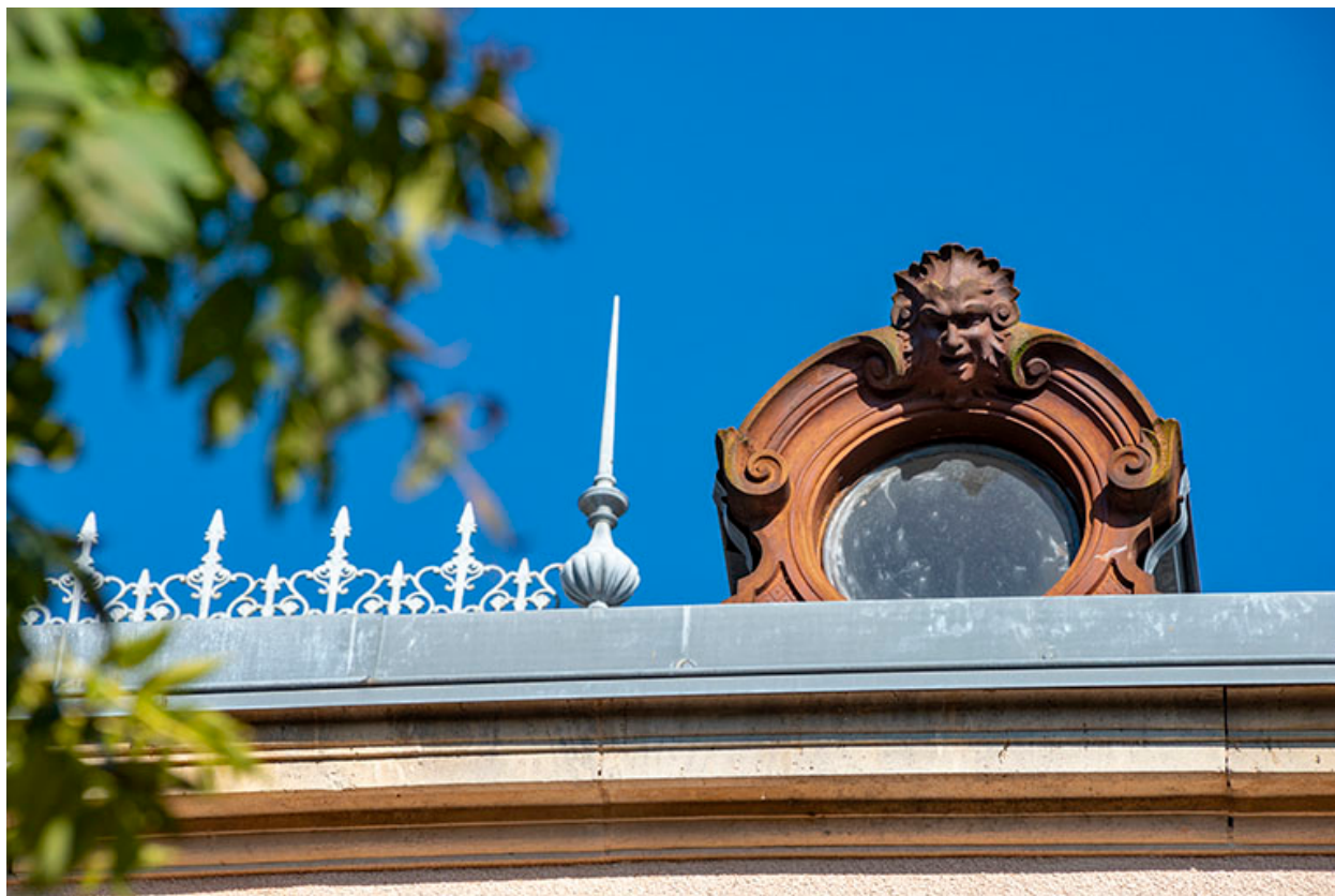
Lucarne, façade postérieure.
