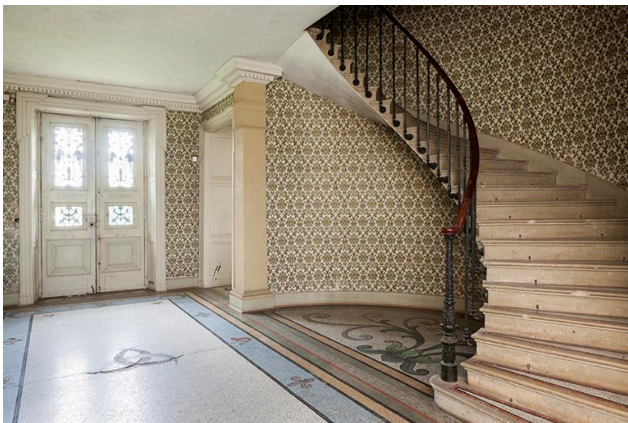
L'escalier en vis suspendu.
