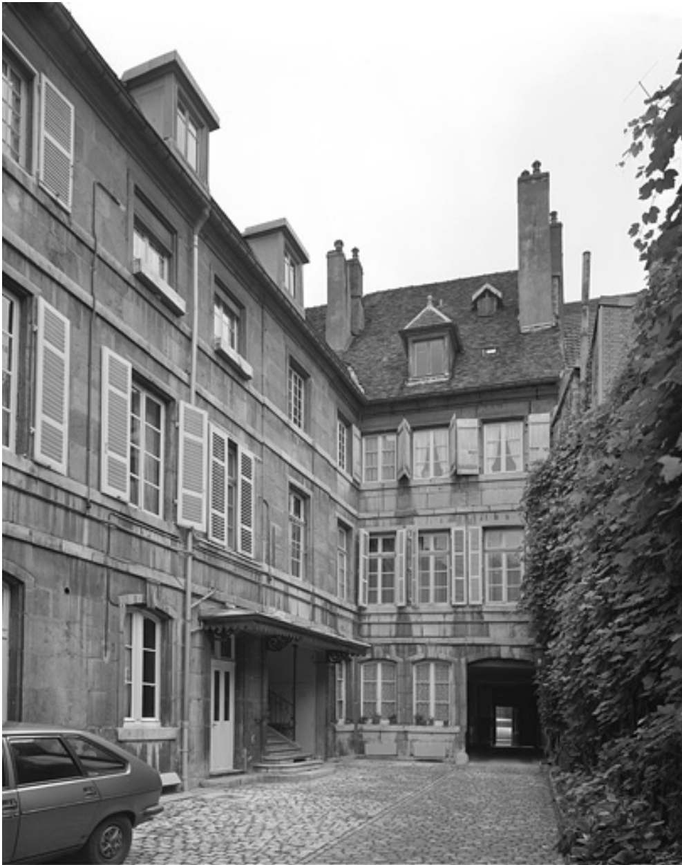
Vue d'ensemble des façades sur cour du logis sur rue.
